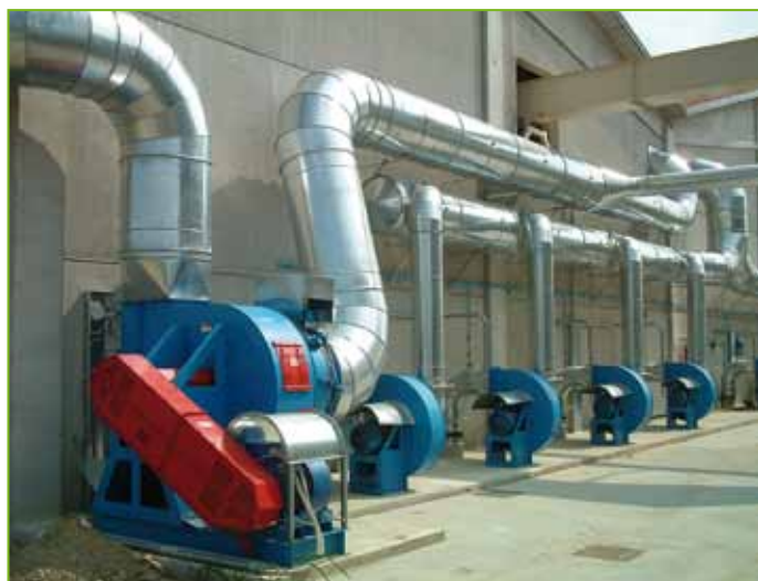
Sistema di insufflazione delle biomasse
