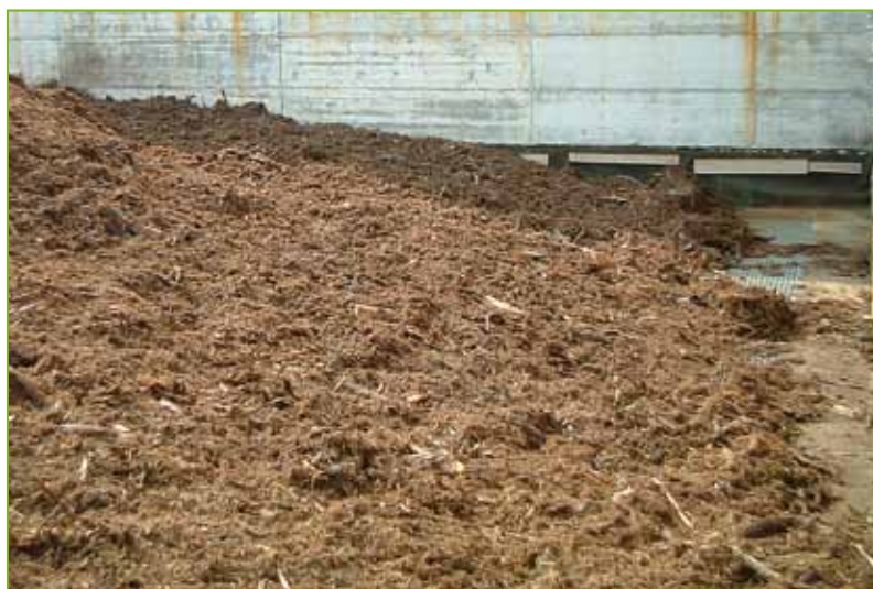
Biofiltro in fase di riempimento
