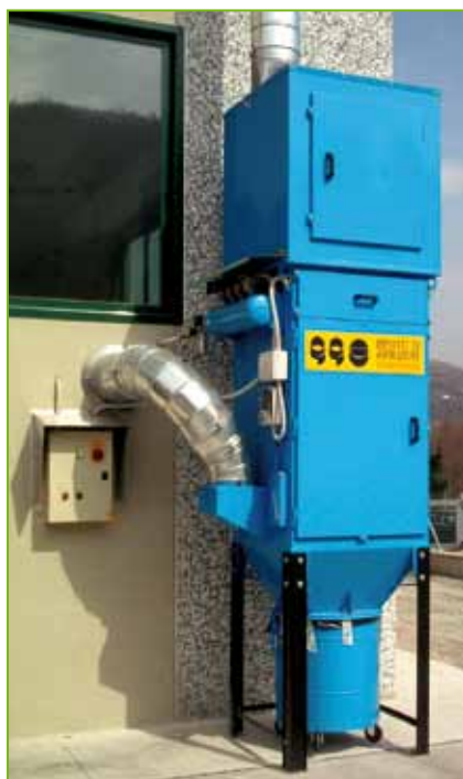
Impianto di aspirazione e filtrazione polveri metalliche da molatura.
