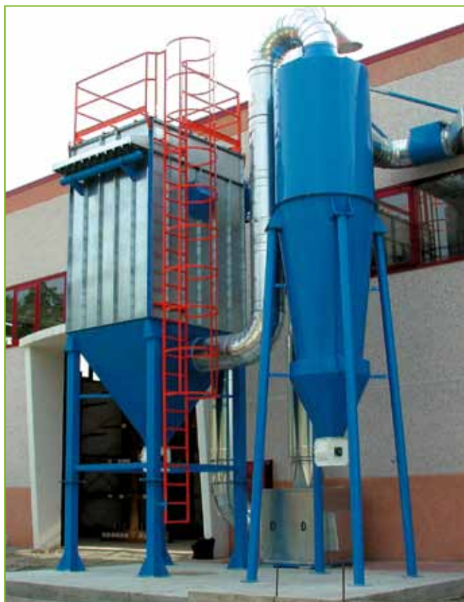
Pre-abbattimento in un impianto di aspirazione e filtrazione di trucioli di alluminio
