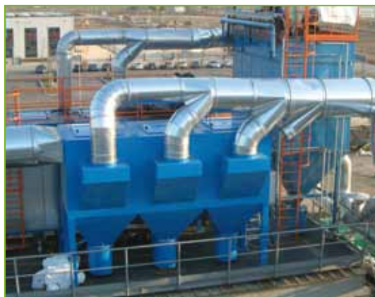
FINPOL GRX 48 Abbattimento polveri su un impianto di trattamento rifiuti tossico-nocivi
