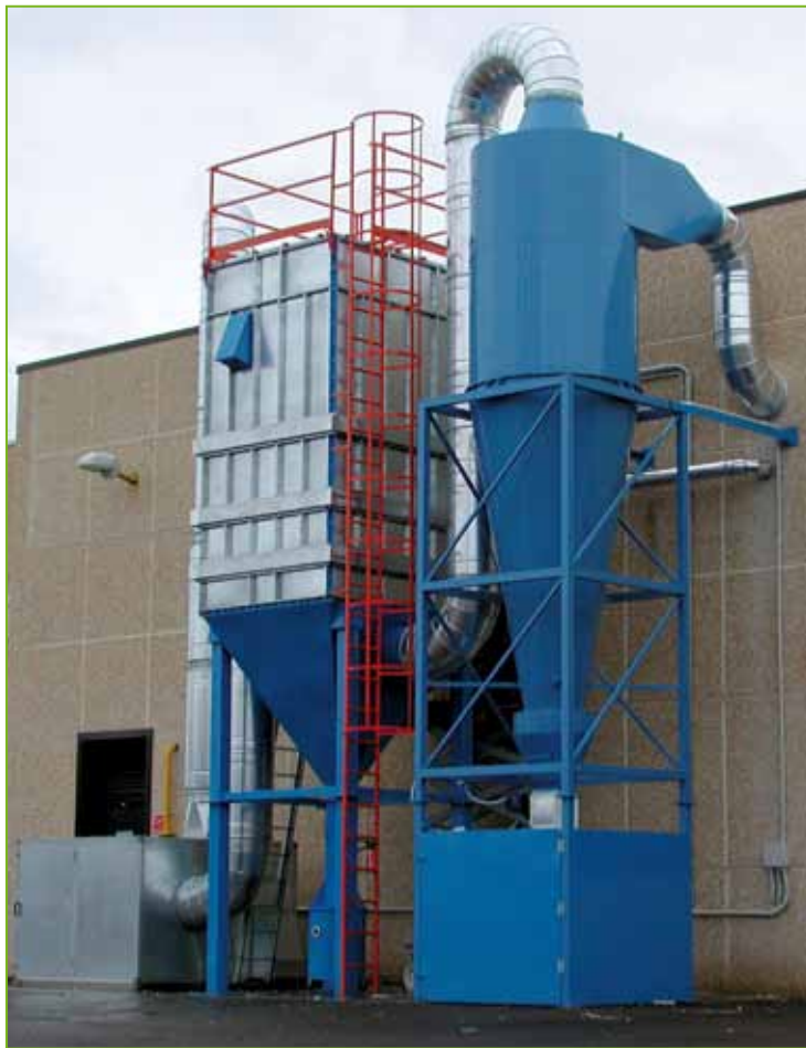
Ciclone ad alta resa di abbattimento, utilizzato come stadio di pre-abbattimento
