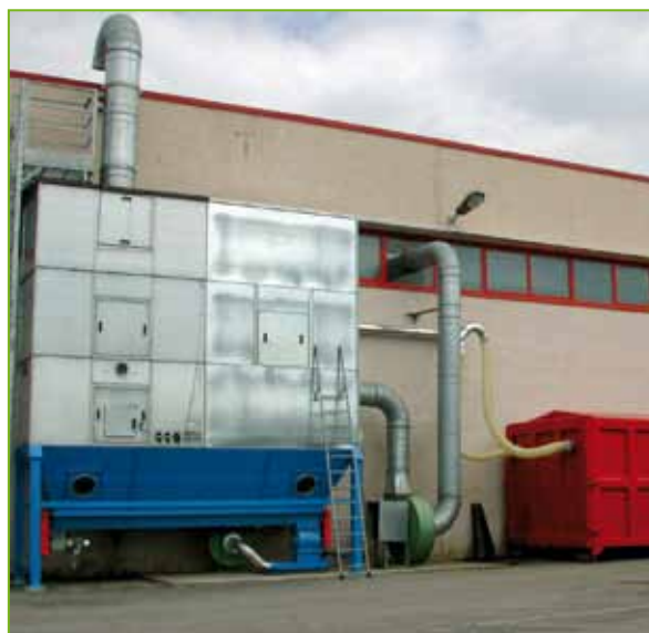
Sottostazione con pulizia a scuotimento
