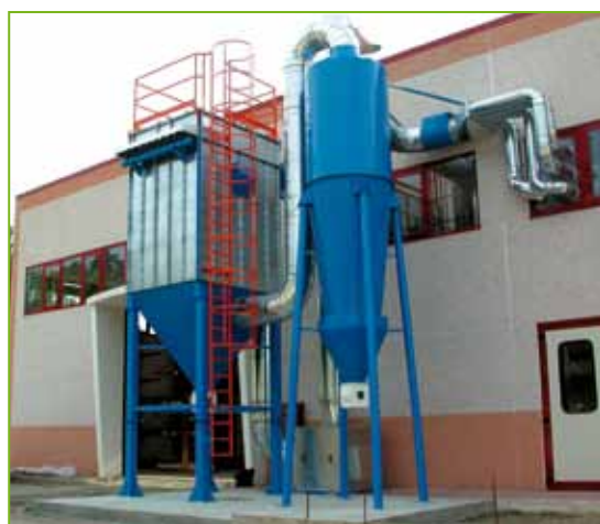
Abbattimento polveri di alluminio
