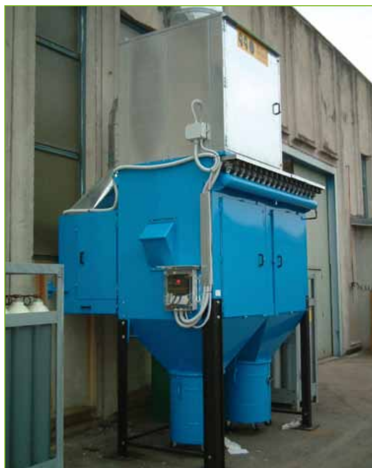
FINPOL con prefiltrazione metallica. Lavorazioni di saldatura e coibentazione.
